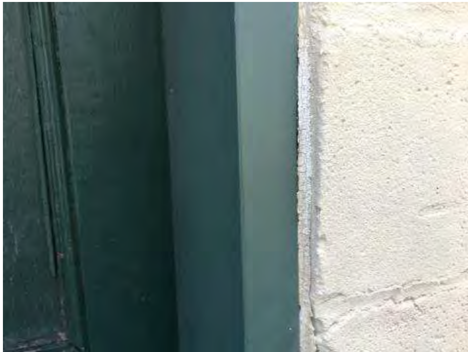
Exterior Gray Door Frame Caulking
